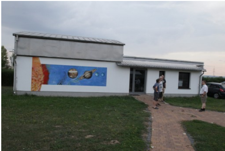
Bild 2: Der Neubau: 2 Spiegelteleskope links, neue Zimmer sind rechts gerade in Arbeit .
